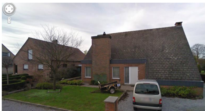
Figure 6 - Photo de la maison
