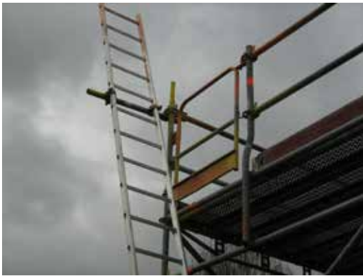
Figuur 37: Toegang via externe ladder & poortje
