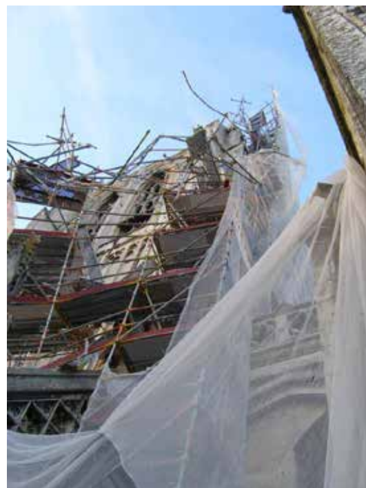
Figuur 51: Gevolg van slechte verankering
