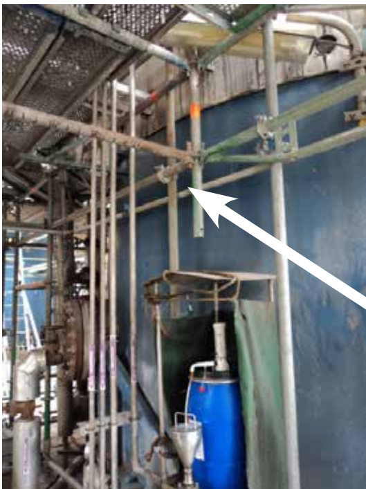
Figuur 22: Verspringing staanderinplanting
