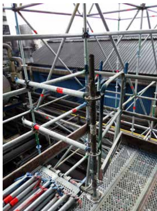
Figuur 36: Geïntegreerde ladder met toegangspoortje
